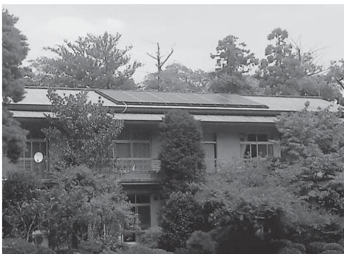
社務所屋根の太陽光パネル
