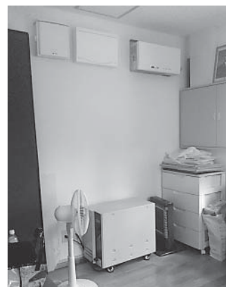
社務所内の蓄電池システム
