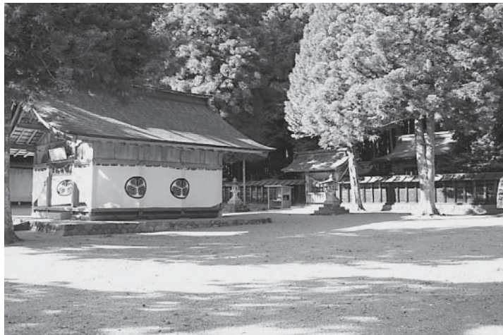
手前拝殿、拝殿奥の山側に江戸時代にあった水車の遺溝がある
