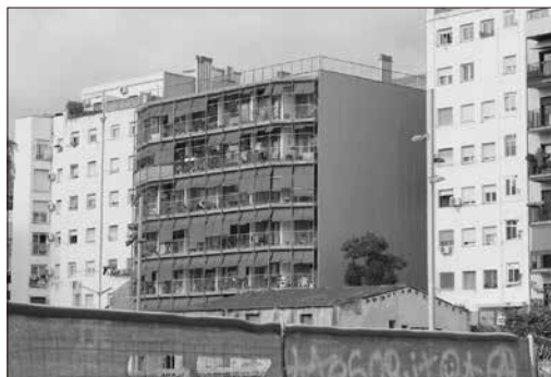
住宅協同組合運営の協同住宅 La Borda。環境にやさしい建築で、屋根には太陽光パネルが設置されている。
